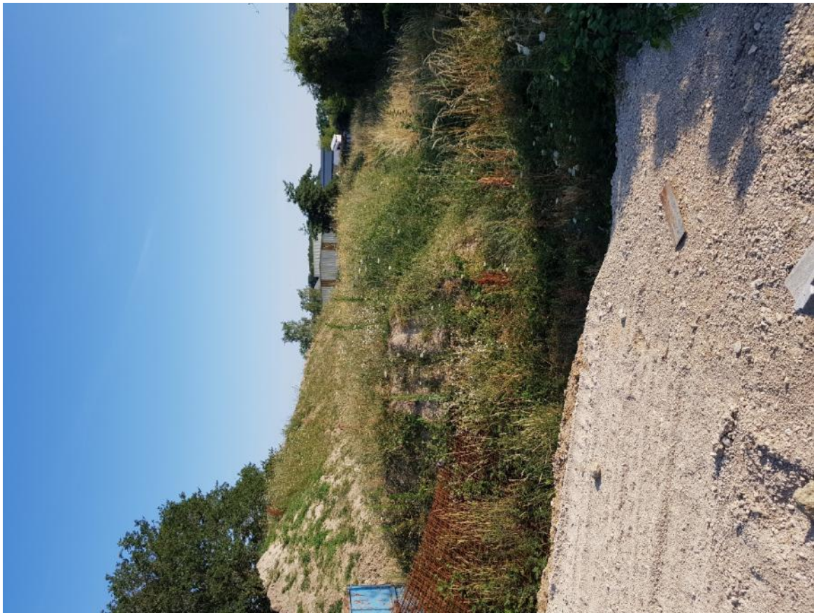
MENUT ST CYR EN VAL : Merlon terres marquées au Pb et au Cu.
